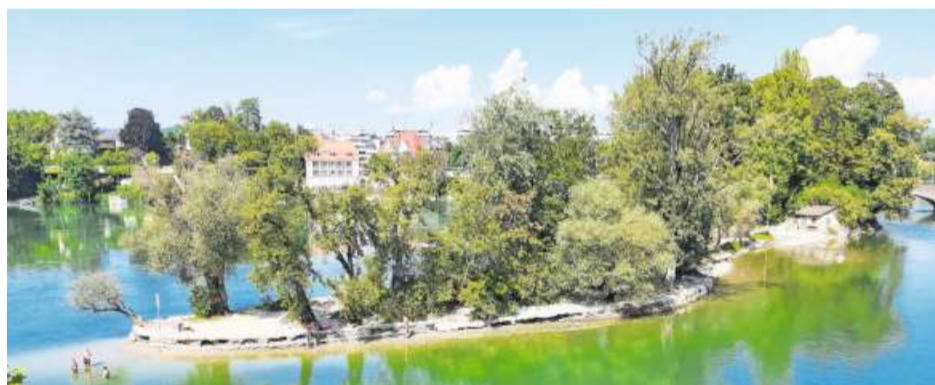
In den kommenden Monaten wird auf dem unteren Inseli das Ufer instand gesetzt. Bild: zvg
